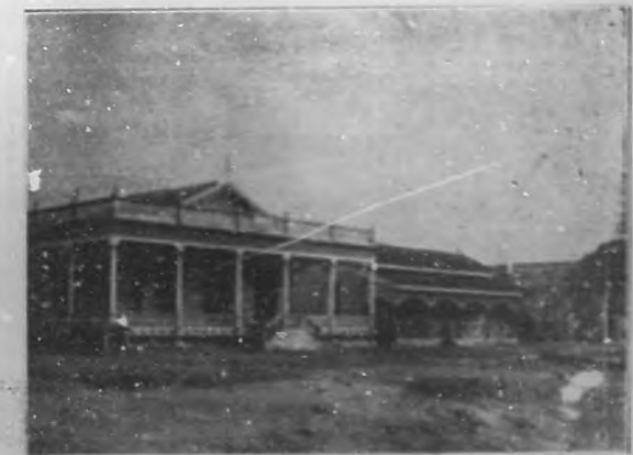
EL CENTRAL "CUBA".—Vista exterior de las oficinas y casa del señor Administrador.
